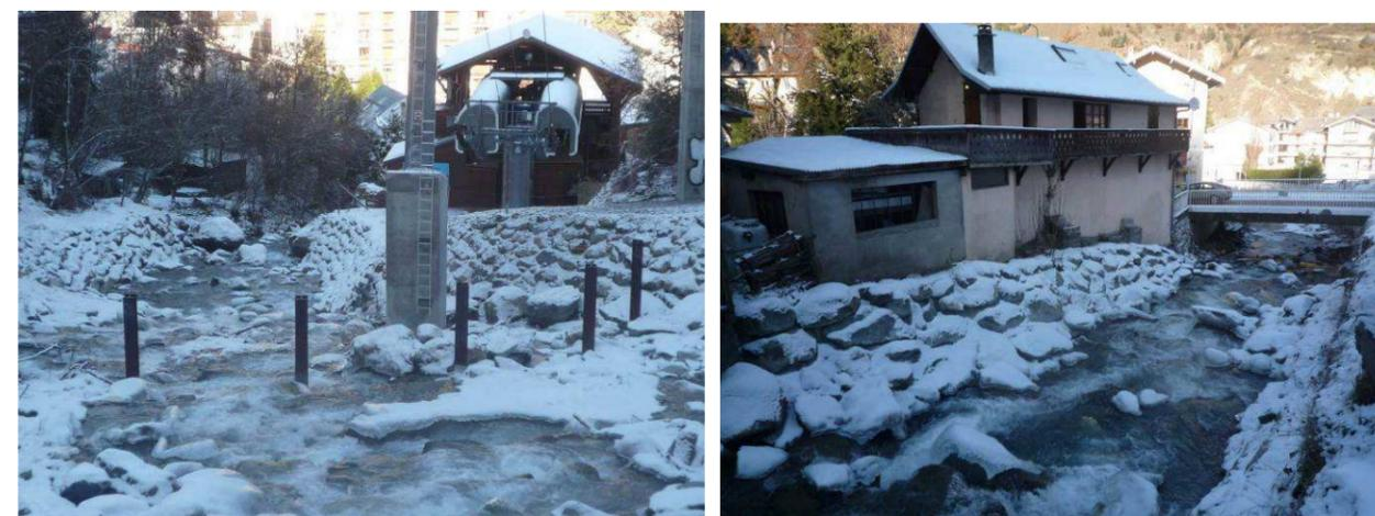
De plus, les enrochements en rive gauche au droit des maisons ont été confortés par bétonnage.
