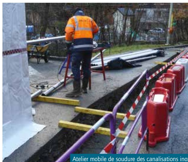
Atelier mobile de soudure des canalisations inox
