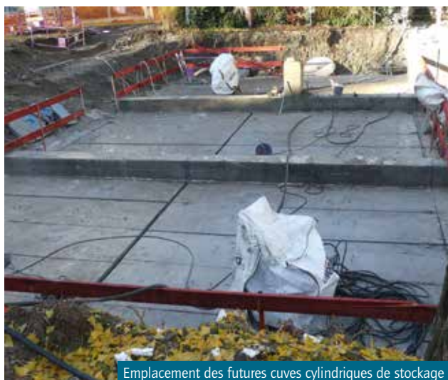
Emplacement des futures cuves cylindriques de stockage
